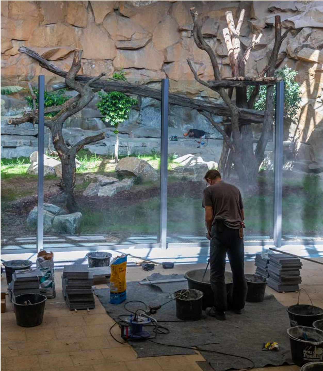
Bauarbeiten im Alfred-Brehm-Haus im Tierpark Berlin
