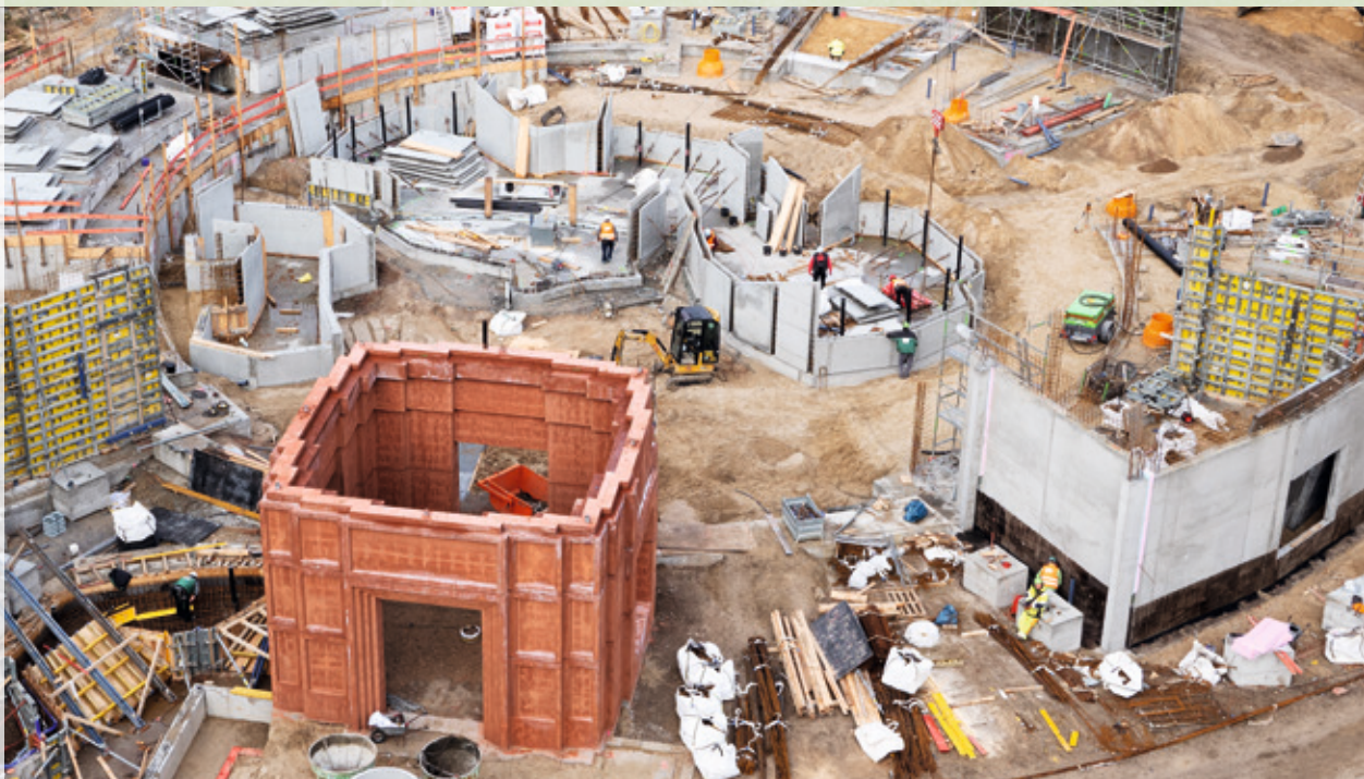
Baustelle der Nashorn-Pagode im Zoo Berlin.
